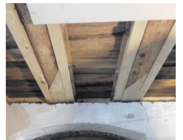
Et annet oppdrag var restaurering/utskifting av råtnete bjelkelag på Breidablikk.
