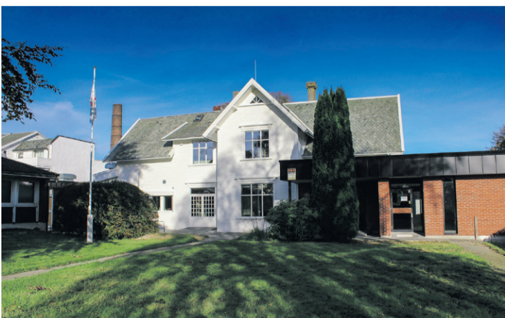
Byggmester O. Torjussen & Sønner var totalentreprenør da Røde Kors-lokalet Østerlide ble renoveret.
